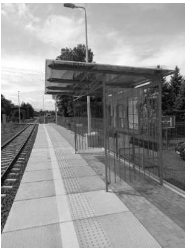
Figura 3-29 - Stația Proszówka (Sursa: Google Earth)
